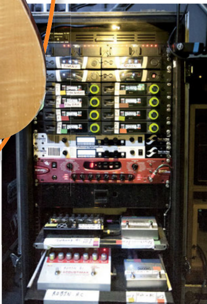
Le rack qui abrite les Torpedos de Robin, le Pod Pro et le BBE Acoustimax.
