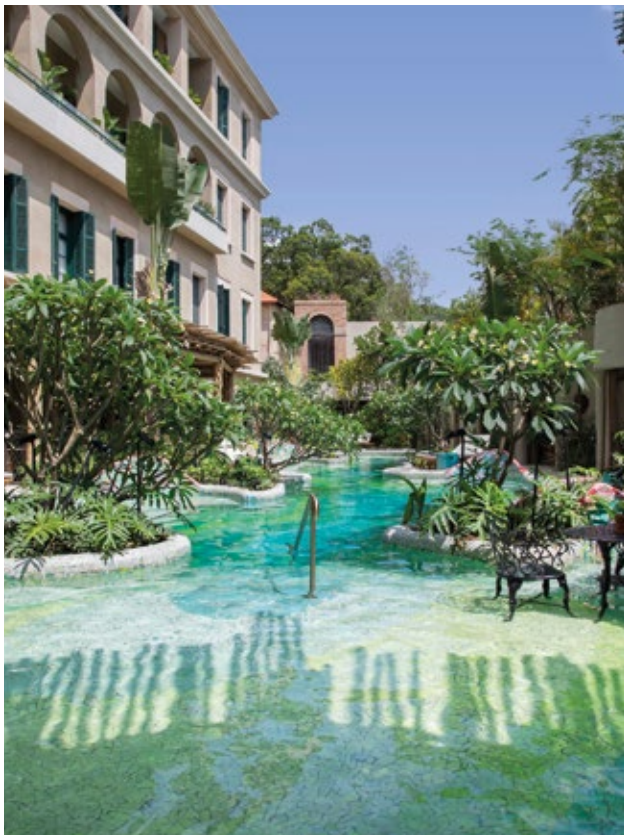
Serpentant entre cabanes et restaurant, cette piscine a été dessinée, avant sa mort en 2016, par le grand artiste brésilien Antonio José de Barros Carvalho e Mello Mourão, dit Tunga. Les architectes ont adapté ses plans.
