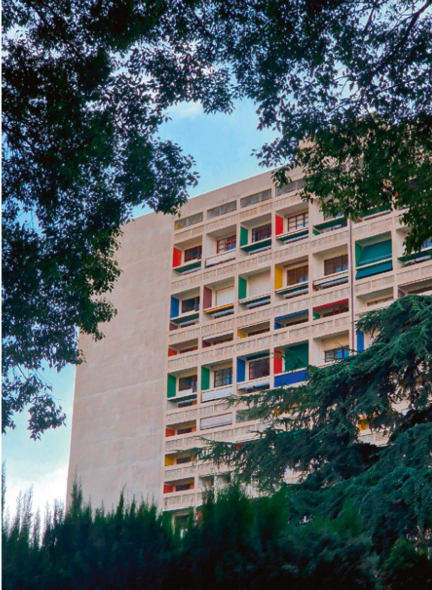
Ci-dessus La façade de la Cité radieuse, monument historique, classée en 2016 au Patrimoine mondial de l'Unesco.
